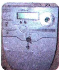
تقوم شركة سونلغاز بتركيب العدادات الكهربائية في البيوت والمحلات وغيرها، سابقاً كانت تستعمل عدادات كهربائية كهروميكانيكية (ذات القرص)، أمّا حالياً فقد بدأت في استبدالها بعدادات كهربائية إلكترونية.
