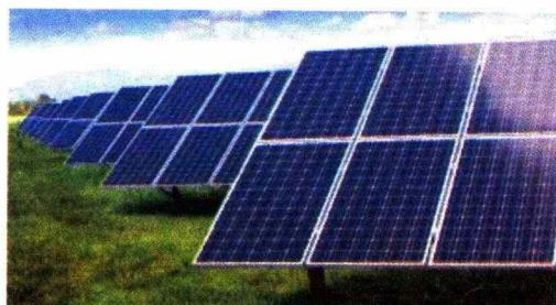
عنصر يتصرف كمولد للتيار الكهربائي عند تعریضه للضوء.
